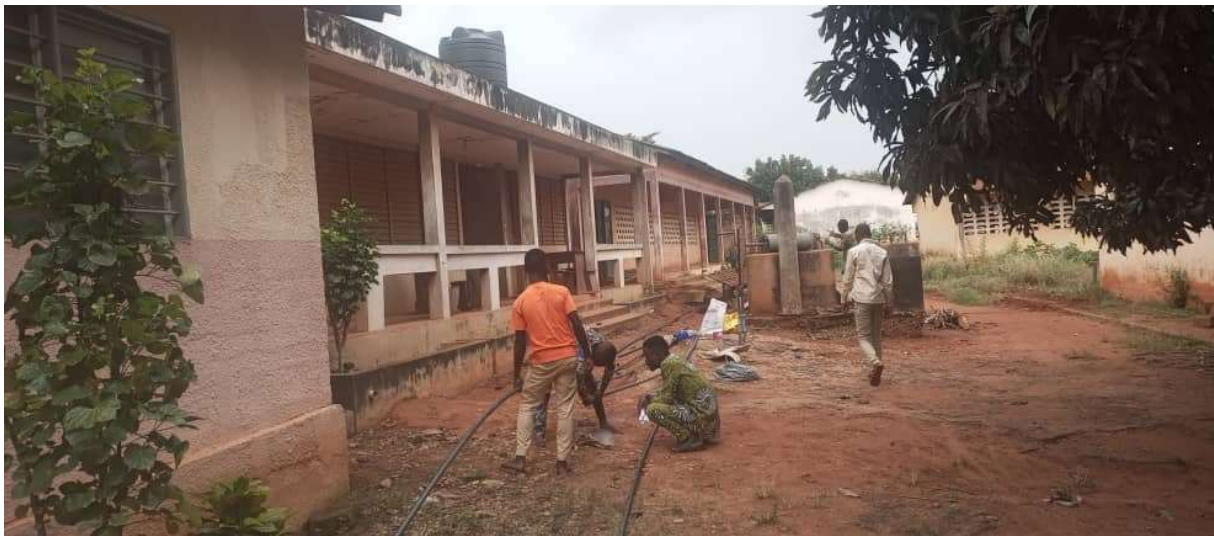
Techniciens à l'œuvre pour le château d'eau
