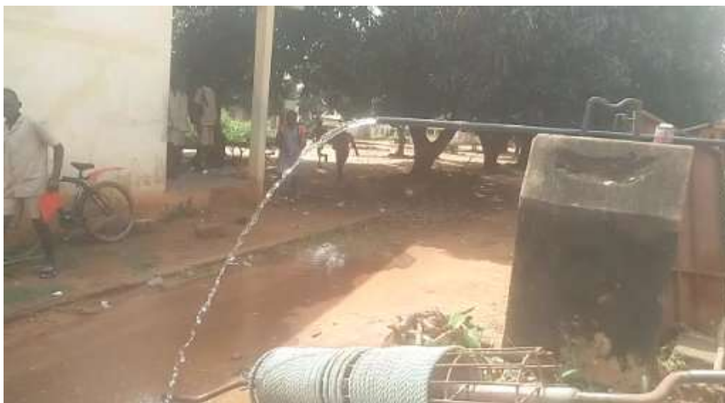
Enfin l'eau potable jaillit
