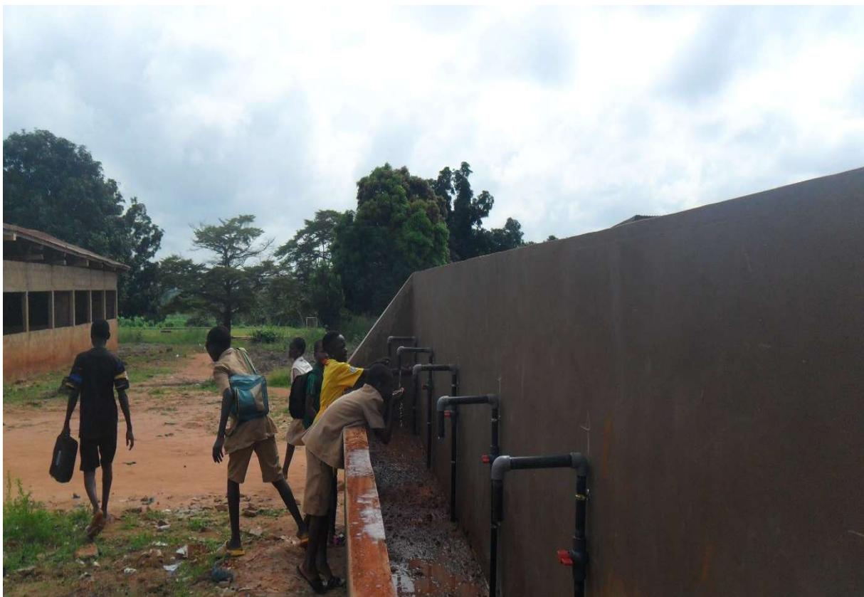
Elèves utilisant l'eau avant la fin de la réalisation du lave-mains
